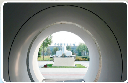
北京惠南庄泵站
