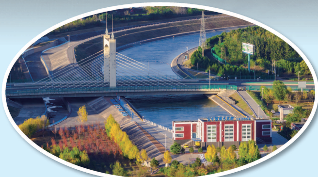
七里河倒虹吸出水口
