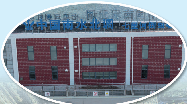
七里河倒虹吸闸口
