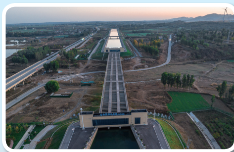
石家庄段泚水渡槽
